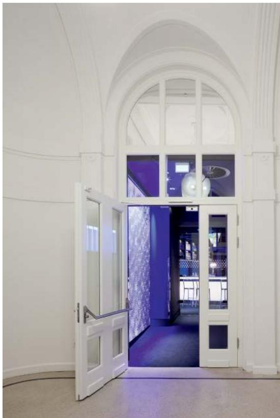
T30 RS Türelement mit Feststellanlage und Panikfunktion nach EN1125
