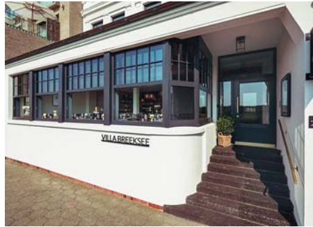
/ Auch Hebefenster aus Holz hat Keizers für den Restaurantbereich geplant und montiert.
